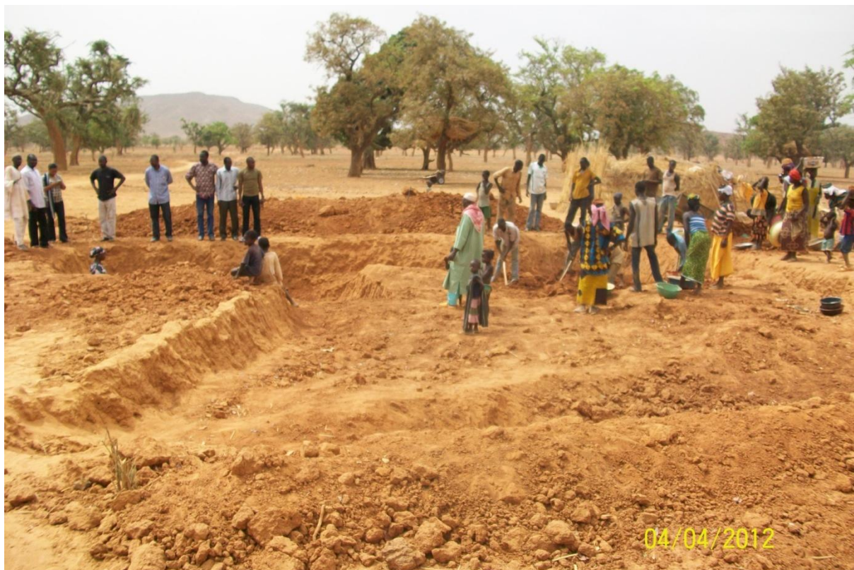
Photo 2 : Niveau d'exécution d'un bassin à côté de Kongoussi (4/04/12)
